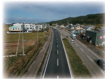
国道舗装修繕
