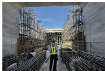
土木工事（カルバートBOX）
