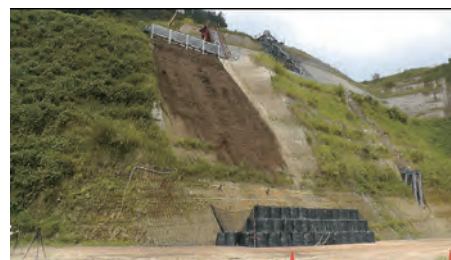
落石・崩壊土砂防護大型土のう擁壁
