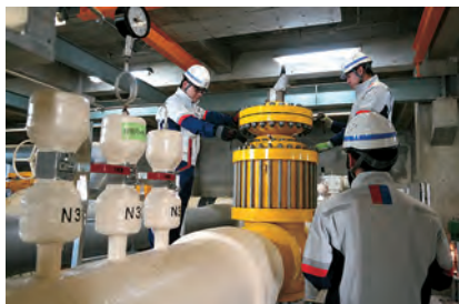
ガス圧力変更設備点検
