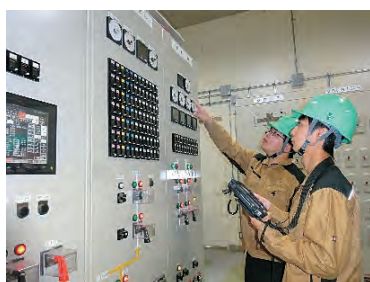
水力発電所パトロール
