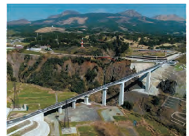
国道325号線 新阿蘇大橋(2021、熊本県)
