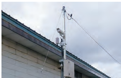
自社開発クラウド 降雪・積雪深計の施工状況 （長岡市中之島支所にて）
