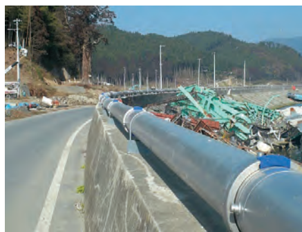
仮設配管レンタル
