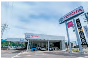
建築工事（ネットヨタ越後魚沼店新築）
