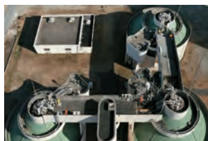
西部水処理センター (施工計画にBIM/CIMを活用/ 工事成績優良者表彰受賞)
