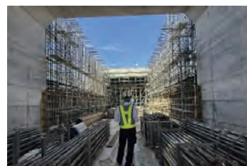
土木工事（カルバートBOX）
