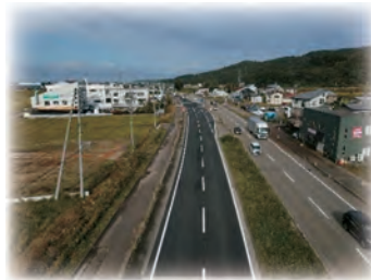
国道舗装修繕
