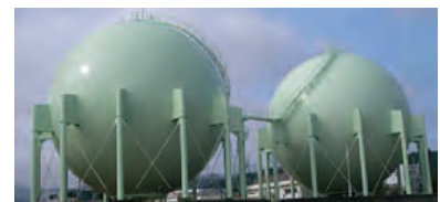
支柱更新工事
