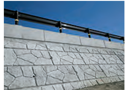
大型積みブロック
