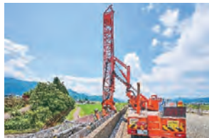
橋梁点検車による土木構造物の点検
