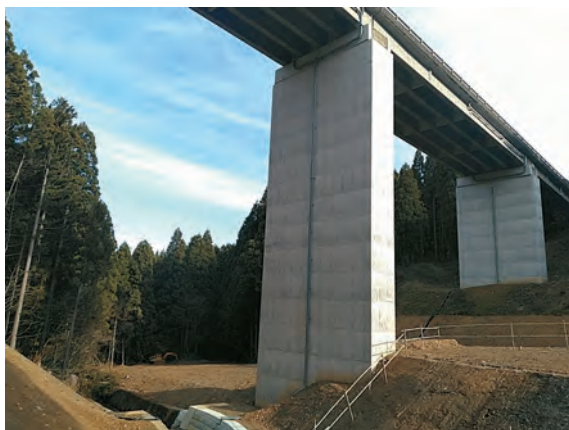
橋梁耐震補強工事
