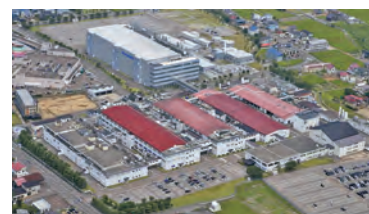
新井地区 全景写真
