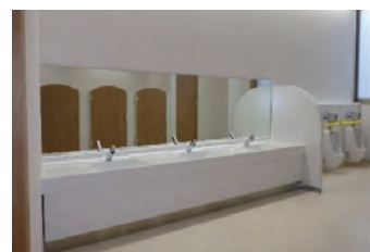
空調給排水設備工事（洗面施設）
