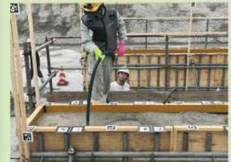
コンクリート締固め技能に関する研究
