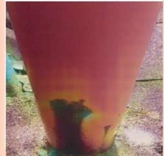
図 1. AI を用いた地際腐食判定の検討
