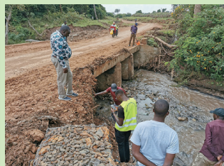
図2 開発途上国における橋梁点検・維持管理の技術支援
