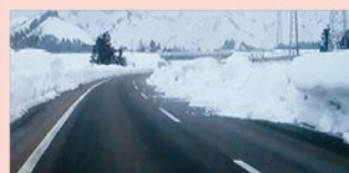
高速道中央分離帯で発生した雪堤崩れ
