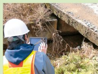
図1 タブレット端末を用いた小規模橋梁点検の効果の検証
