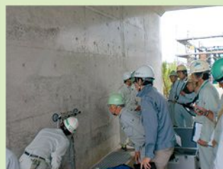
図3 表面吸水試験装置 (SWAT) を用いたコンクリートの品質調査
