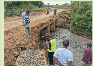
図2 開発途上国における橋梁点検・維持管理の技術支援
