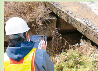
図1 タブレット端末を用いた小規模橋梁点検の効果の検証
