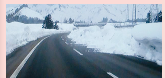
高速道中央分離帯で発生した雪堤崩れ
