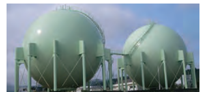
支柱更新工事
