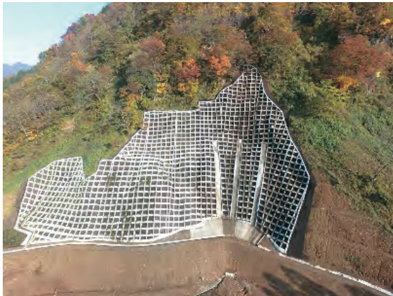
地すべり防止工事
