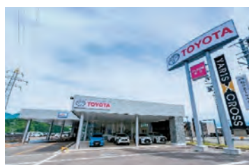
ネットトヨタ越後魚沼店新築工事
