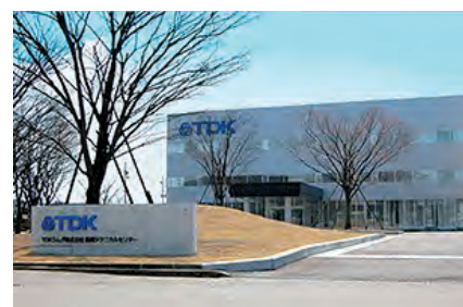
長岡テクニカルセンター
