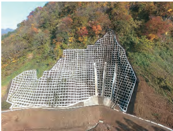
地すべり防止工事
