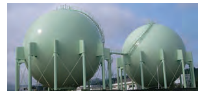
支柱更新工事
