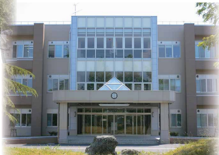
正面玄関 Front Entrance
