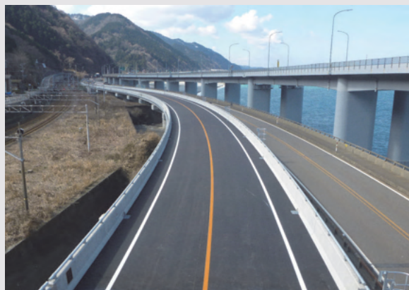
歌高架橋(糸魚川市)
