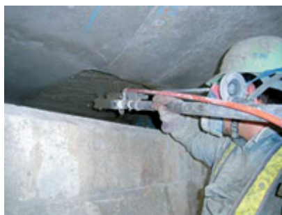
桁端狭小部ウォータージェットはつり、吹付けによる断面修復
