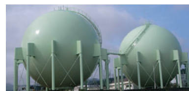
支柱更新工事
