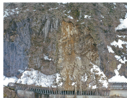
土砂崩れの現場
