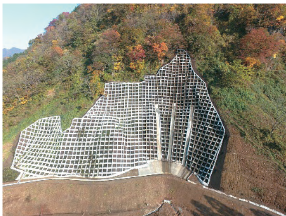
地すべり防止工事
