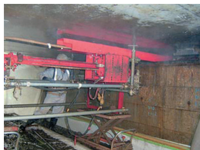
桁端狭小部ウォータージェットはつり、吹付けによる断面修復
