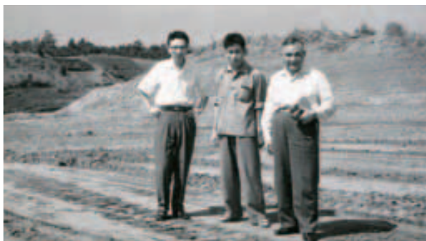
昭和36年9月8日 整地中の工事現場を視察する山崎貫三短大学長(右端)ら
