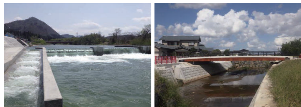
新発田市小戸 加治川右岸頭首工ゲート設備
