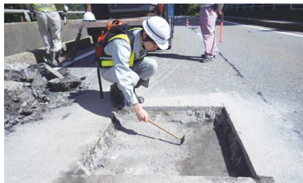
橋の点検調査も行っています。
