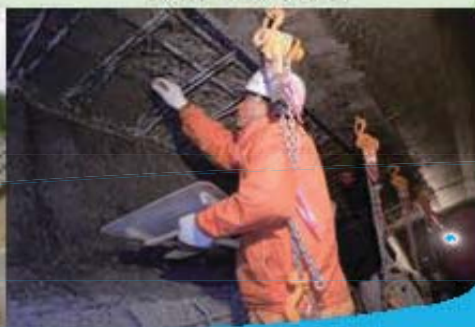
補修工事 風景
